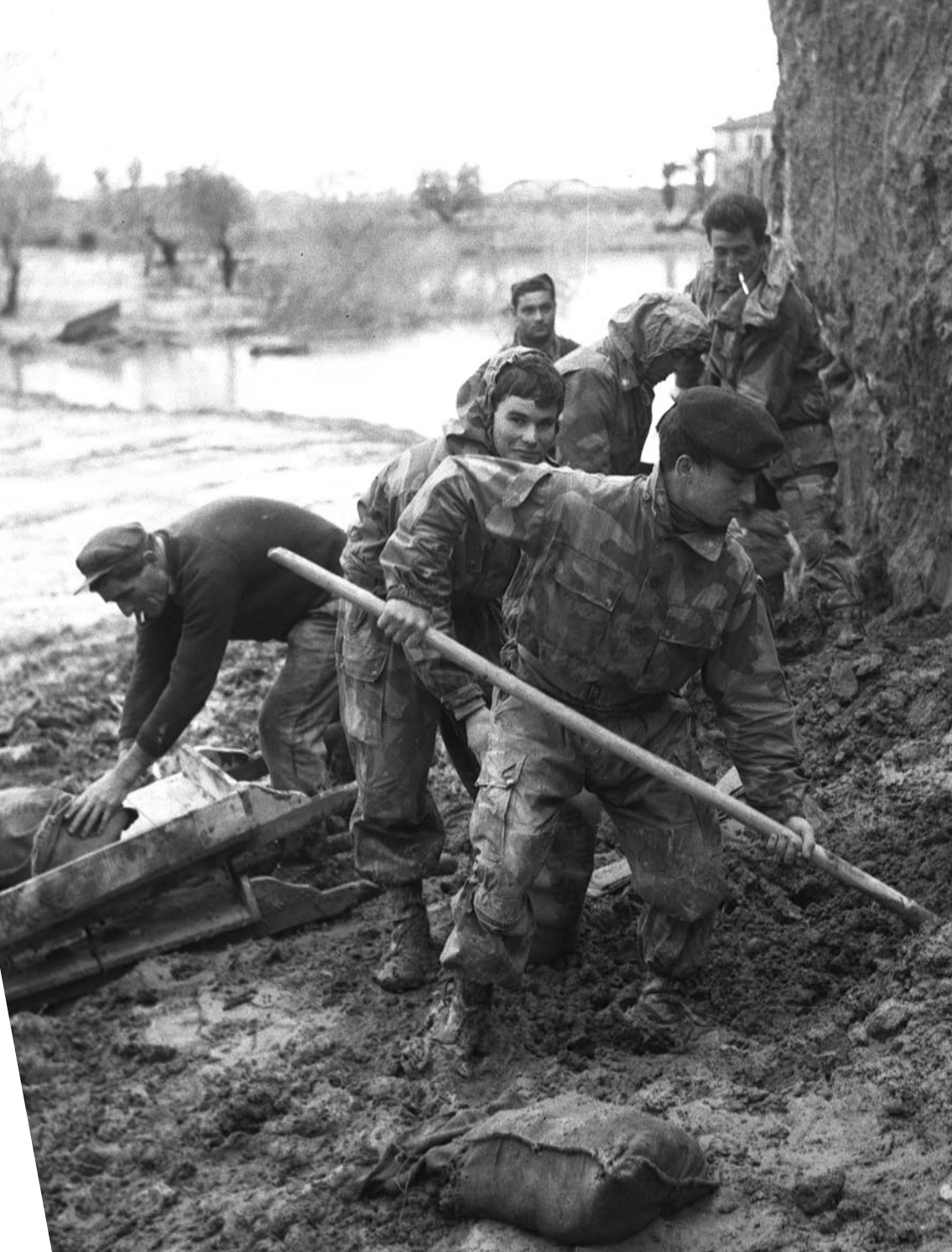
GROSSETO ALLUVIONE DEL 1966
